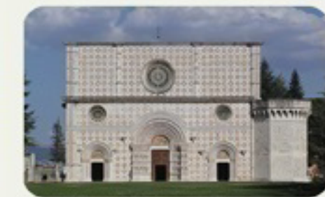
Basilica di Collemaggio
